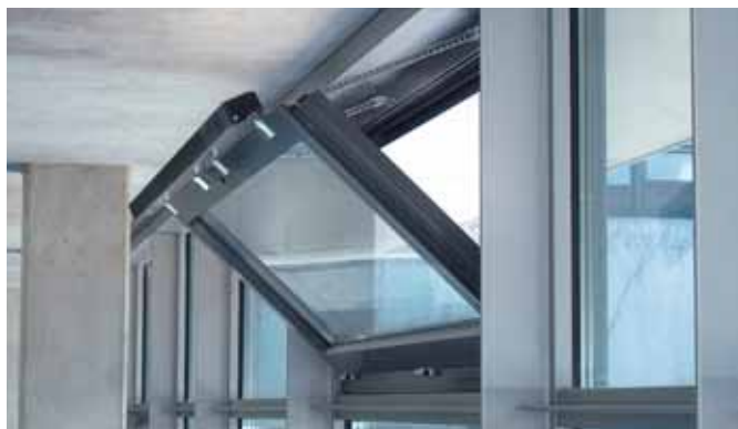
Цепные приводы обеспечивают идеально дозированное проветривание помещения с шириной открывания створки до 750 мм
